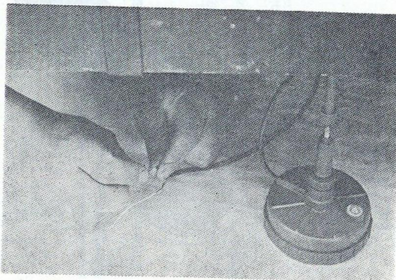
Sl. 72d. Povezivanje detonatorske kapsle sa upaljačem
